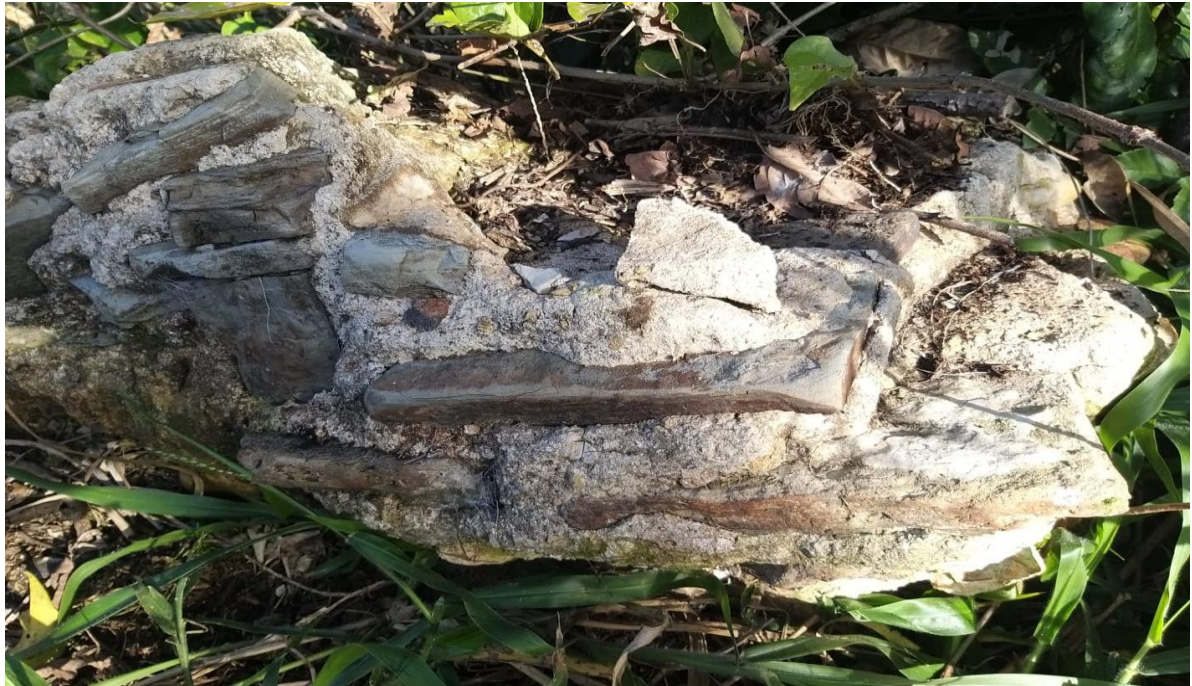
Bloco de alicerce destruído de antiga edificação da Colônia Thereza. Fonte arquivo pessoal 2022.
