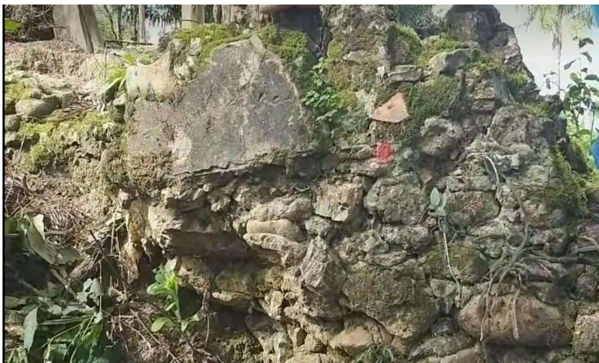
Alicerce no local que seria a origem da Colônia Thereza. Sem datação e ainda intacto, feito com pedras e argamassa específicas. Fonte: Acervo pessoal 2022.
