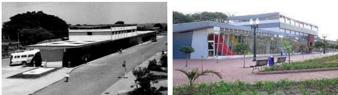
Figura 13 - Fotografias da Antiga Rodoviária, hoje Estação da Luz de Campo Mourão.
