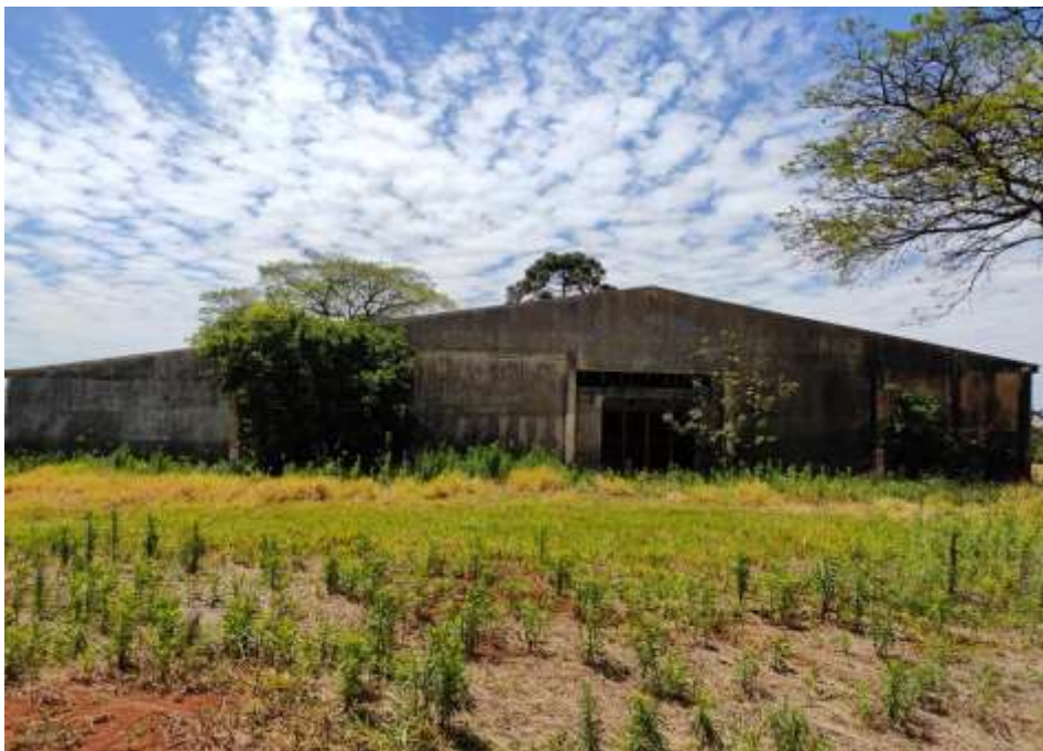
FIGURA 30: O atual Clube 7 de setembro, abandonado. FONTE: acervo da própria autora. AUTORIA: da própria autora.
