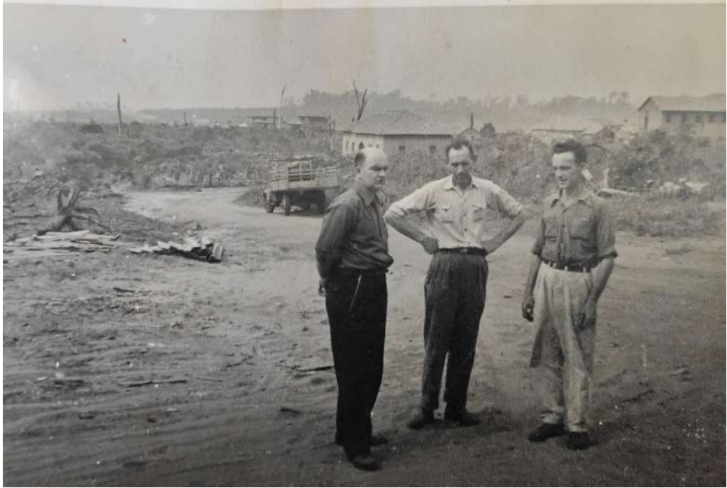
FIGURA 1: As ruas da comunidade. FONTE: Acervo pessoal da família Appelt Anhaia. AUTORIA: desconhecida.
