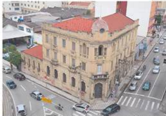
O início das intervenções no Palacete Scarpa se arrasta desde 2013, quando a prefeitura obteve a liberação de R$ 499.778,51, proveniente de convênio firmado com o governo federal.
