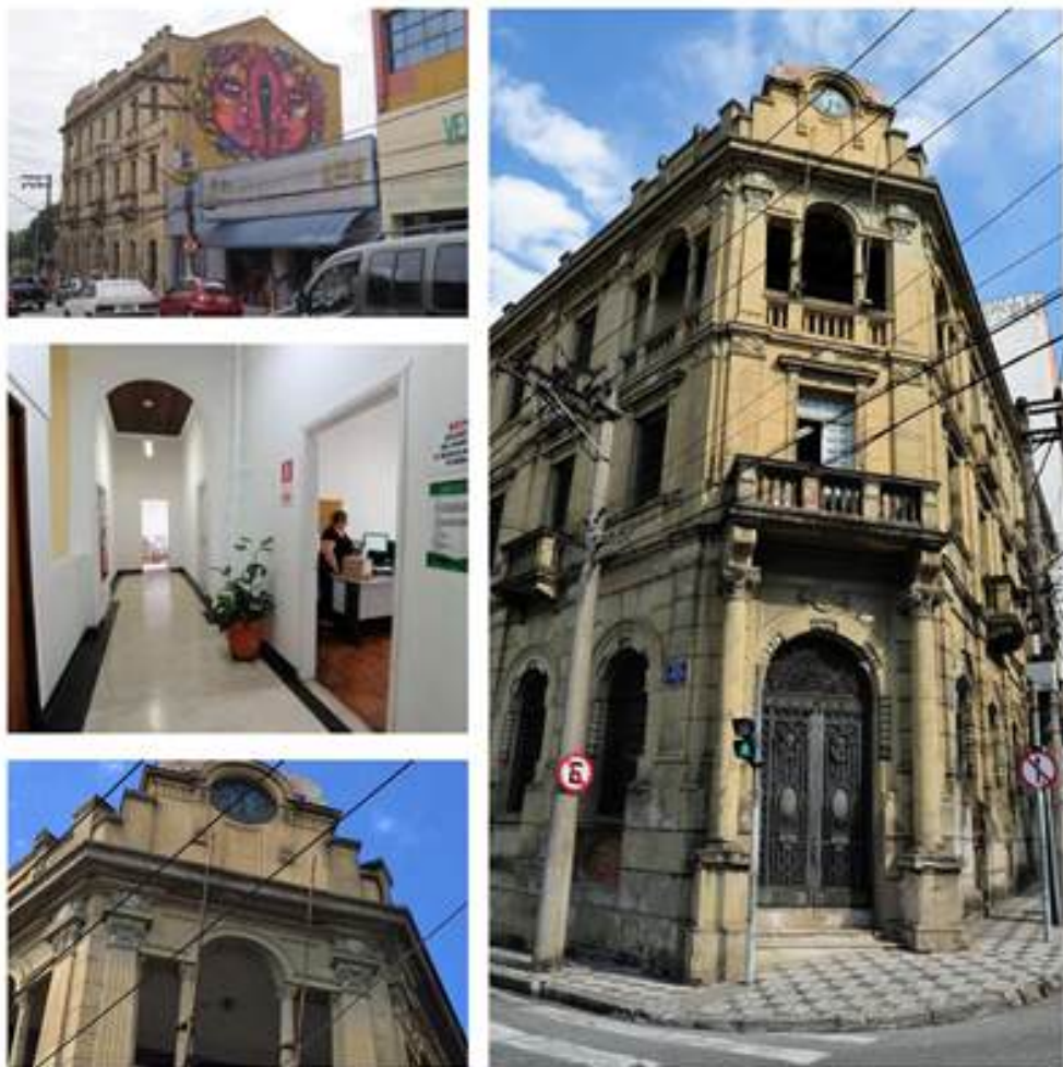
Figura 6 — Fotografia atual do Palacete Scarpa, 2018.
