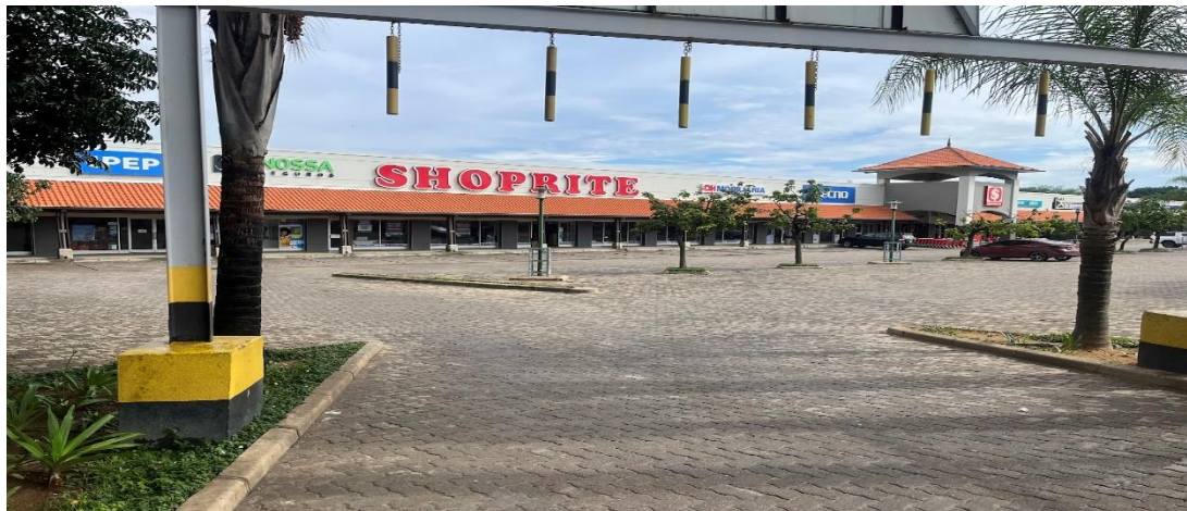
Imagem 11 - Galeria do Supermercado Shoprite
