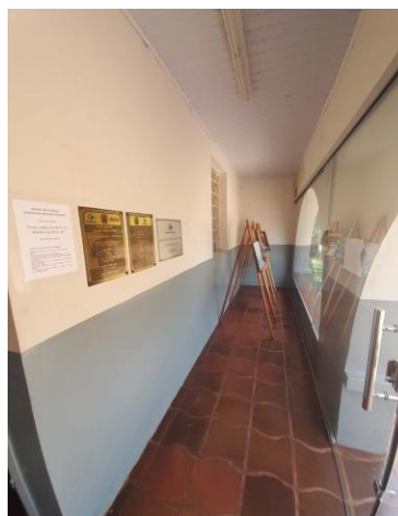
Figura 10 – Varanda fechada por vidro
